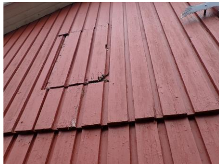
Luckan till vindsingången är rötskadad
