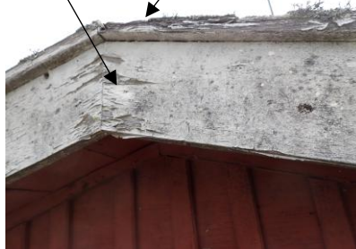
Vind- och vattbräda över balkongdörr rötskadade
