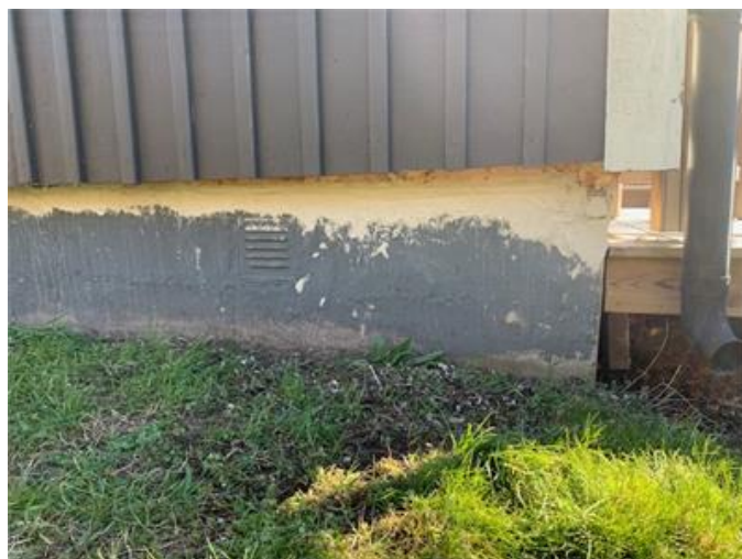
Højning av tillbyggnadens hörn. Synlig väggssyll.
