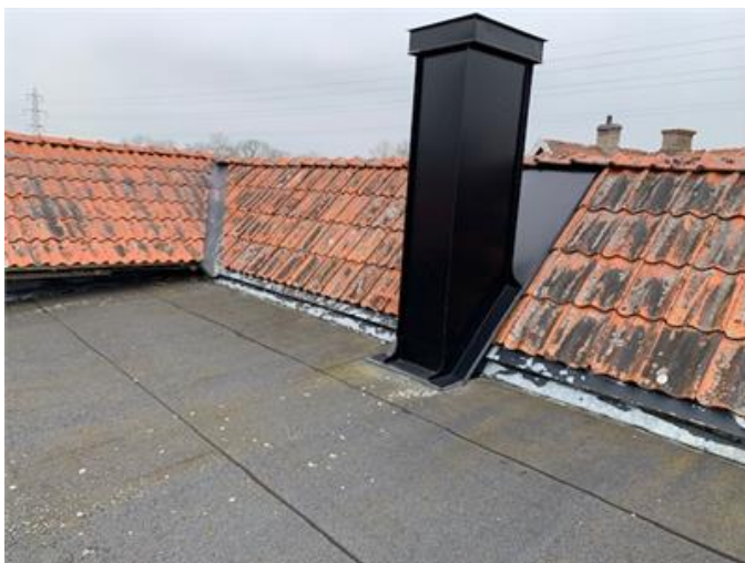
Låglutande papptak, plåtdetaljer med färgsläpp, äldre tak med tegelpannor samt plåtbeklädd skorsten.
