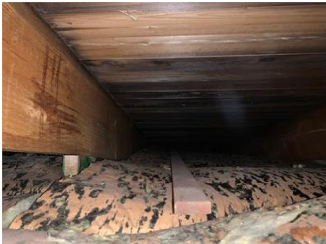
Mikrobiell påväxt i parallelltaket.
